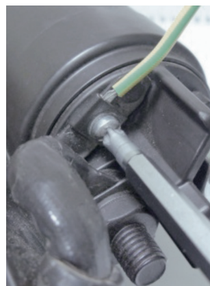
Figure 3 : Câble connecté à la borne 50 de l'interrupteur magnétique
